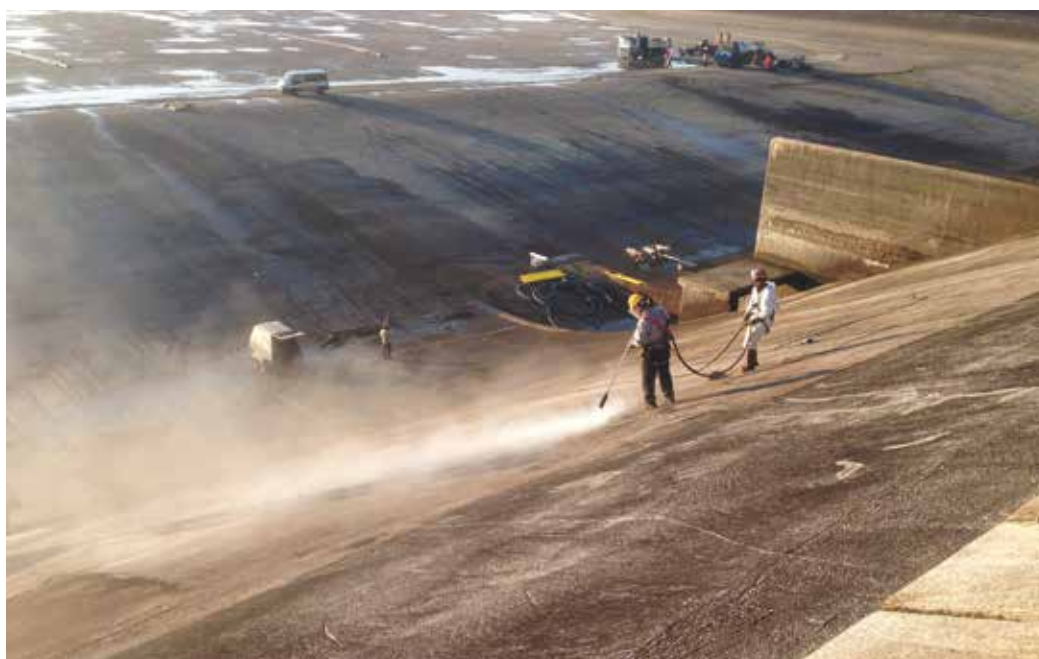
4. Le operazioni di pulizia del paramento
