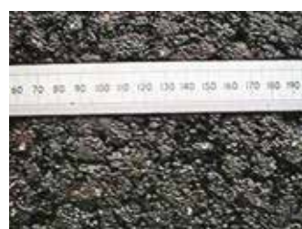
11. Un particolare della tessitura di un conglomerato chiuso
