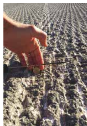
12. La superficie stradale dopo la fresatura
